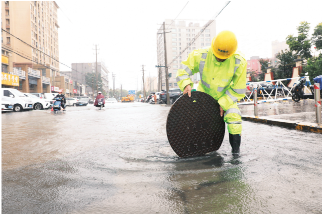
◀ 8月10日，抢险人员在江苏常州一处积水路段进行排水作业。 新华社发
