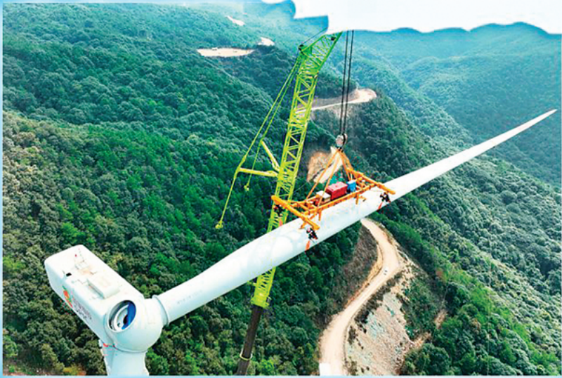
↑第三片风电叶片吊装现场。
