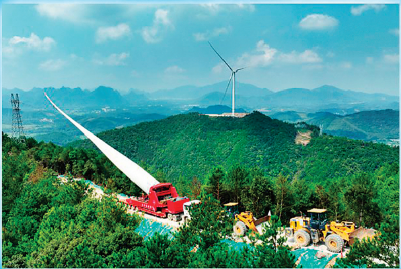
↑第三片风电叶片运输至安装现场。
