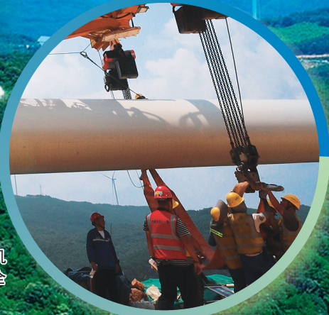
←烈日下，工人合力安装单叶片吊具。
