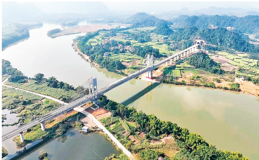
南凭高铁崇凭段上金左江双线特大桥。
