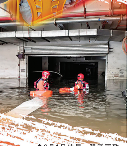
↑6月1日凌晨,强降雨致地下车库被淹,消防部门奋战近15小时排涝。
