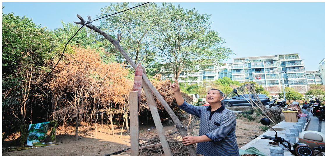
居民秦先生说这是居民们自发搭建的,用来支撑垂落电缆线的简易木架。
