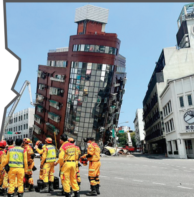
↑3日，地震造成花莲市一栋大楼严重倾斜。新华社发
