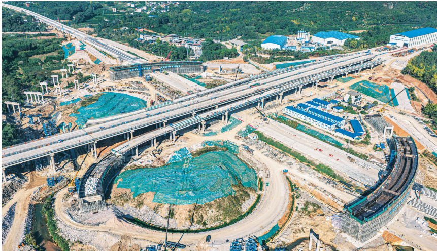
▲项目现场。 通讯员阳海翔 摄
