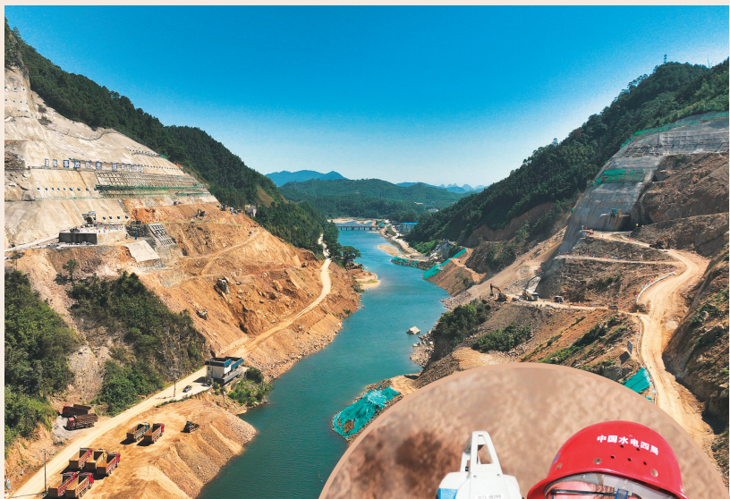
▲长塘水库工程施工现场。
