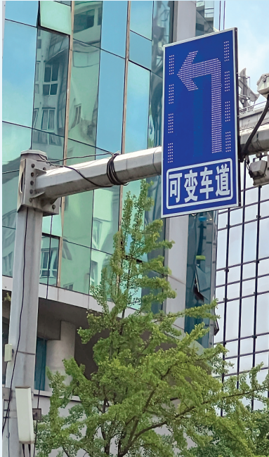
▲ 此次启用的可变导向车道可根据需要调整行驶方向，并通过LED实时显示。
