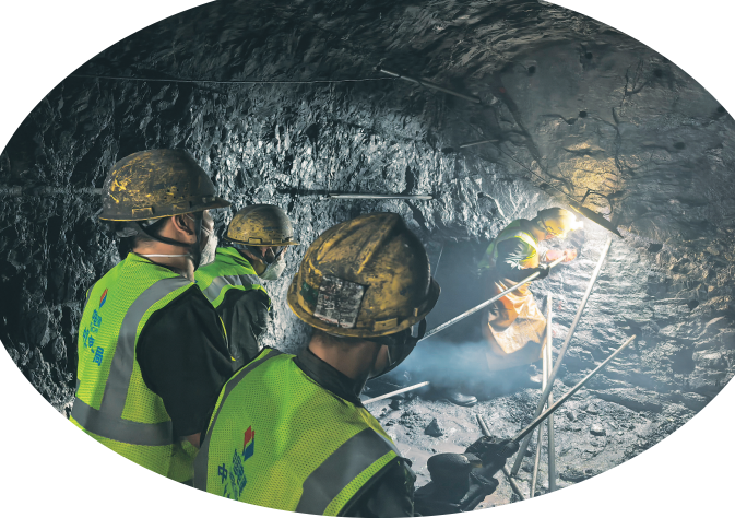
▲长塘水库工程项目建设现场。
