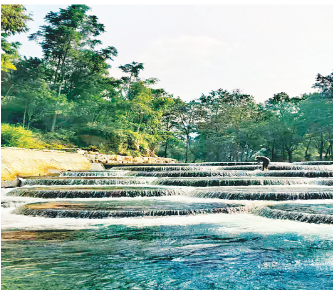
▲灵川南圩地表水综合治理与地下河协同调蓄项目修复后的鱼鳞坝。
