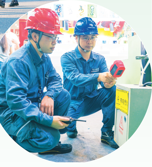
▼ 9 月 19 日，南方电网广西桂林临桂供电局保电工作人员驻点值守旅游展区现场，确保供电安全可靠。 王航平 摄
