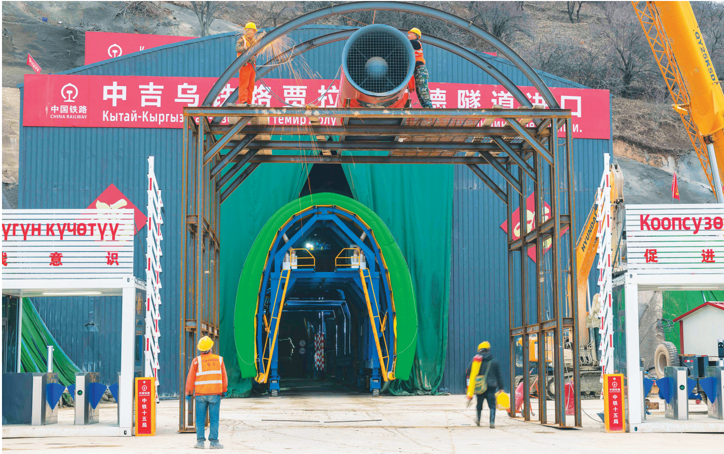
▲ 2026年2月11日，在吉尔吉斯斯坦贾拉拉巴德州，中国建设工人为中吉乌铁路贾拉拉巴德隧道安装隧道通风设备。 新华社发
