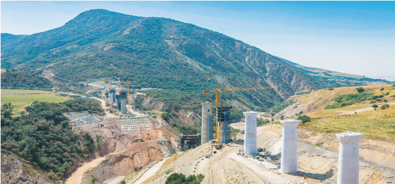
▲这是8月15日在吉尔吉斯斯坦贾拉拉巴德州拍摄的中吉乌铁路克奇阿勒特河特大桥工程施工现场（无人机照片）。新华社记者李任滋 摄
