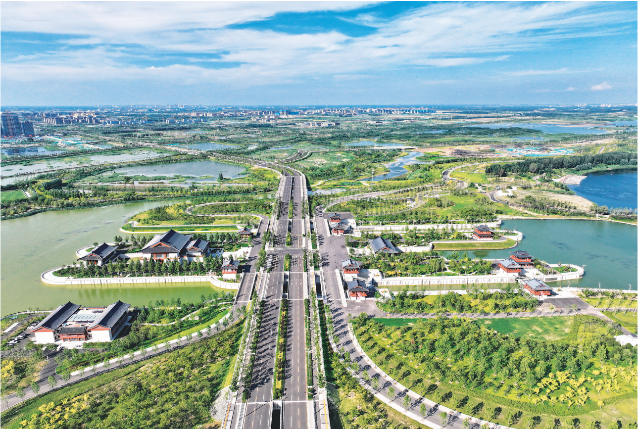
▲这是位于雄安新区启动区与白洋淀交汇处的南河枢纽（2026年8月4日摄，无人机照片）。 新华社记者牟宇 摄
