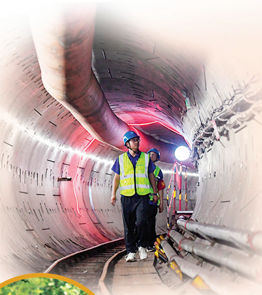
▲ 2024 年 7 月 30 日，天津市滨海新区雨污分流改造工程项目雨水主管隧道顺利贯通，工作人员在雨水主管隧道内检查盾构管片。 新华社记者赵子硕 摄
