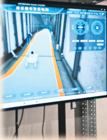
▲ 2025 年 4 月 15 日，四足巡检机器人在雄安新区雄东电缆隧道内巡检。 新华社记者牟宇 摄
