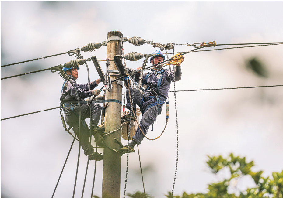
►工人在检修线路。通讯员阳海翔 摄
