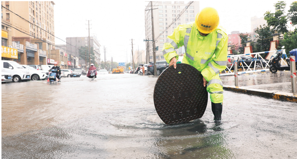
▲8月10日，抢险人员在江苏常州一处积水路段进行排水作业。 新华社发（陈曙摄）
