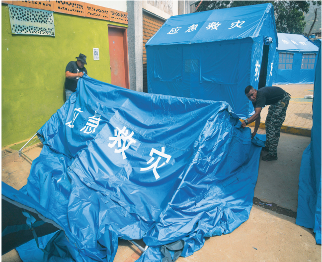
▲7月10日，在委内瑞拉北部拉瓜伊拉州一处临时营地，玻利瓦尔国民武装部队的成员搭建由中国提供的应急帐篷。新华社发
