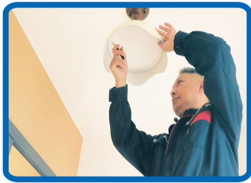
◀物业工作人员为业主维修电灯。（全州县融媒体中心供图）
