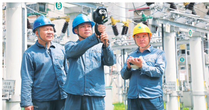
▲工作人员正在巡检变电站。 俞超 摄
