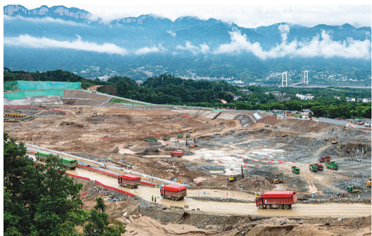
◀这是6月8日拍摄的三峡水运新通道工程先行开挖区施工现场。新华社记者 伍志尊 摄
