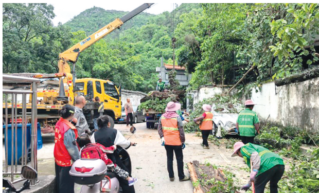
◀社区志愿者在现场维护秩序，确保工人专业安全地清障作业。 穿山社区供图
