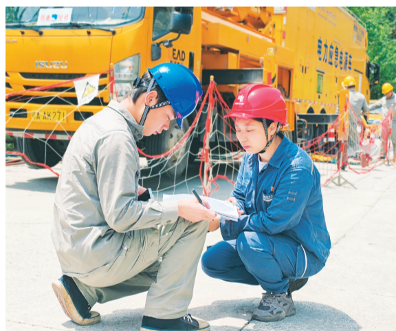
▲“五一”假期期间，南方电网广西新电力投资集团龙胜供电有限公司的工作人员坚守岗位，筑牢供电安全防线。 韦伟 摄
