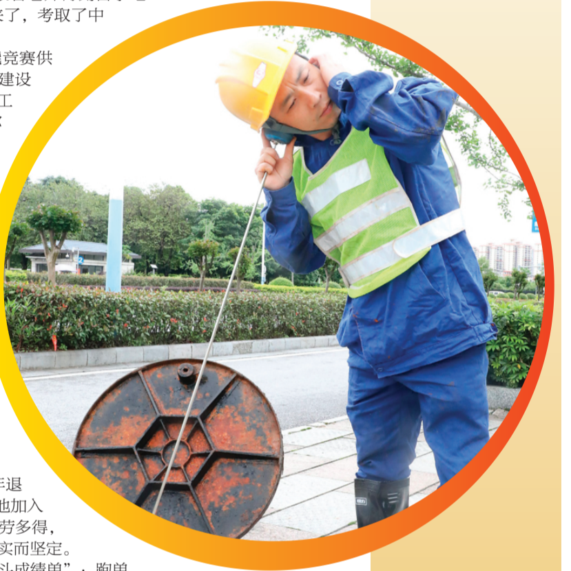
▼叶永初用听漏棒“听音”辨别哪里有漏水。 记者陈静 摄
