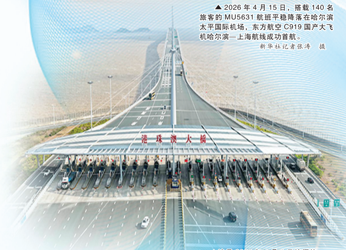
▲这是2026年1月6日拍摄的港珠澳大桥出入口（无人机照片）。
