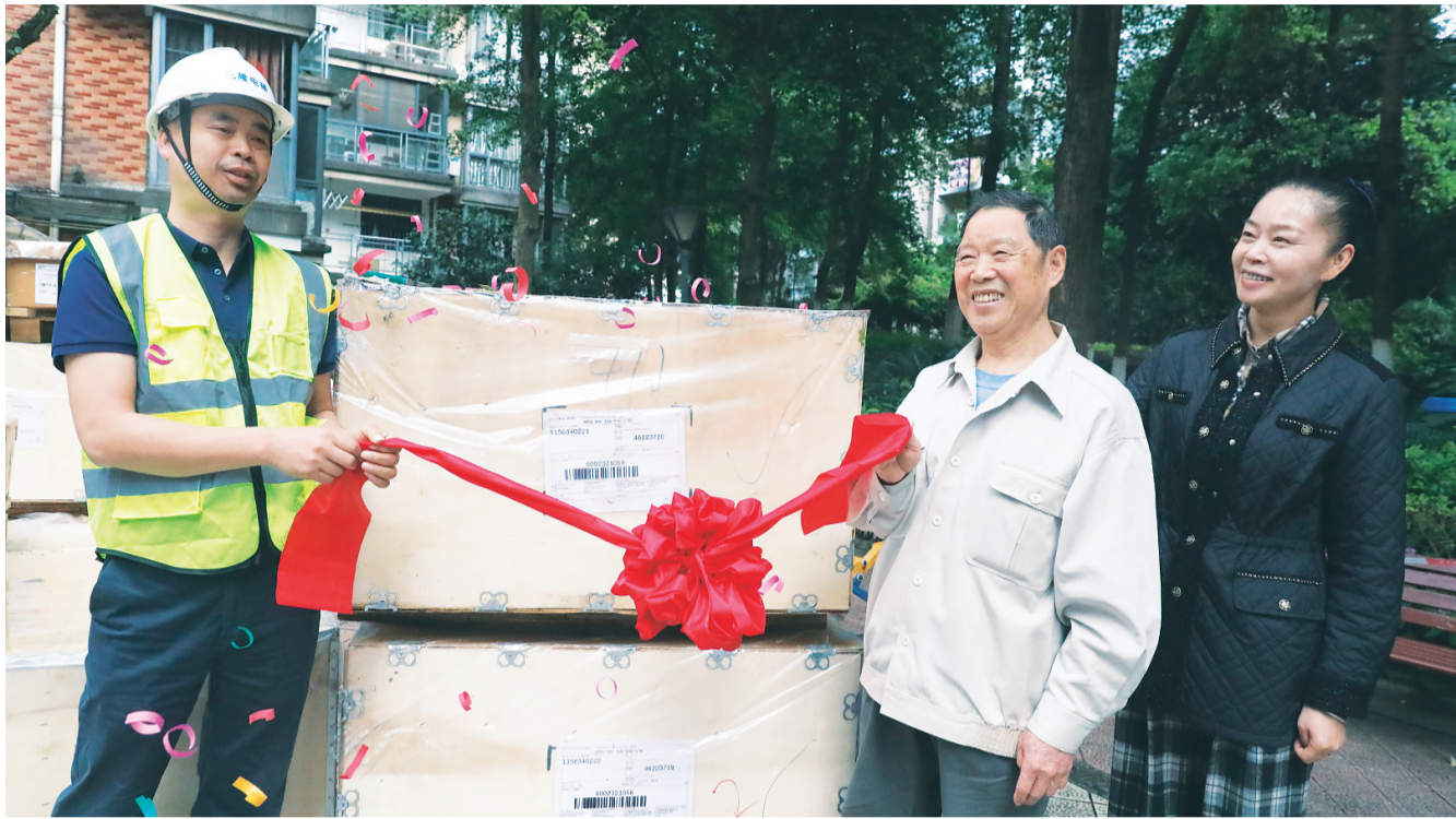
▲由业主代表和电梯施工方共同参与的开工仪式。
