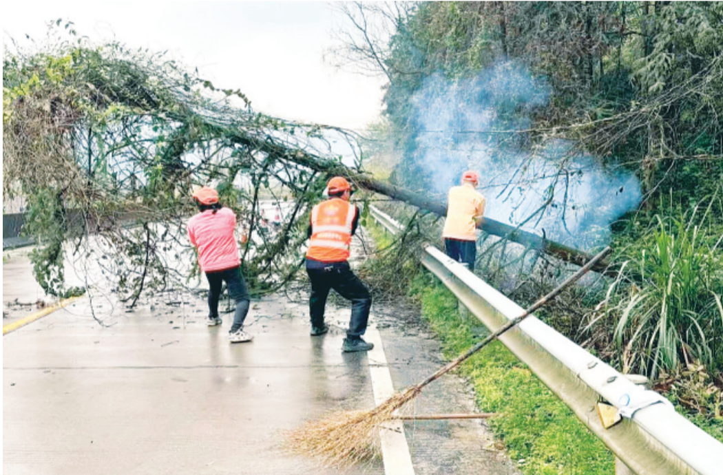
▲公路养护人员清理倒伏路树。 通讯员吴全德 摄
