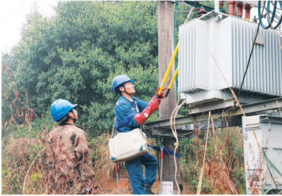
▲施工人员在挂设接地线。 通讯员俞超 摄
