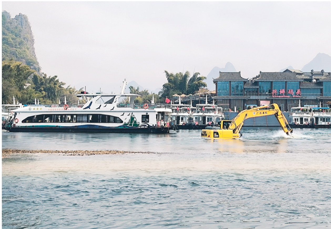
▲工作人员正操作挖掘机对航道浅滩清淤疏浚，保障漓江航道安全畅通。 通讯员白开荣 摄
