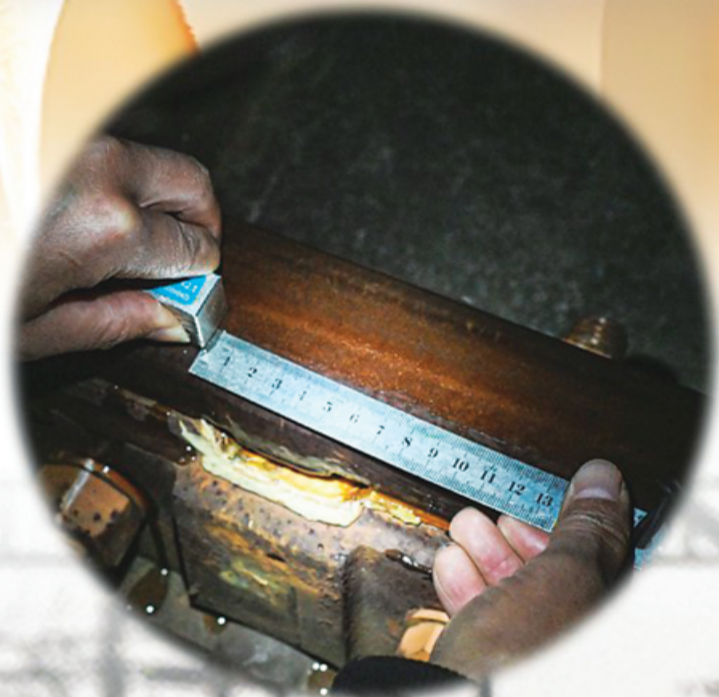
▶探伤工通过焊缝仪复查一处疑似伤损。
