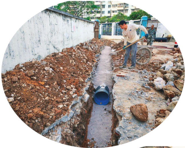
▲金隆苑小区的排污管道在进行改造。（叠彩区委宣传部供图）
