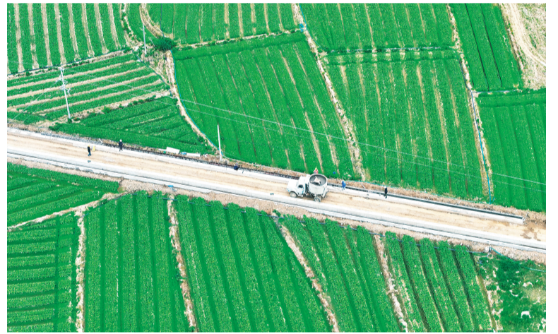
▲恭城水利项目施工现场。李茂香 摄
