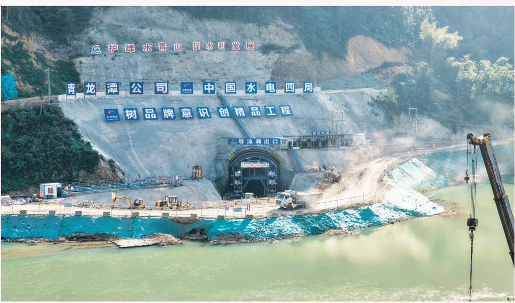
▲长塘水库工程导流洞出口施工作业面现场。
