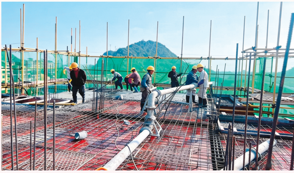
▲桂林市万福配型保障性住房项目梁板浇筑施工现场。
