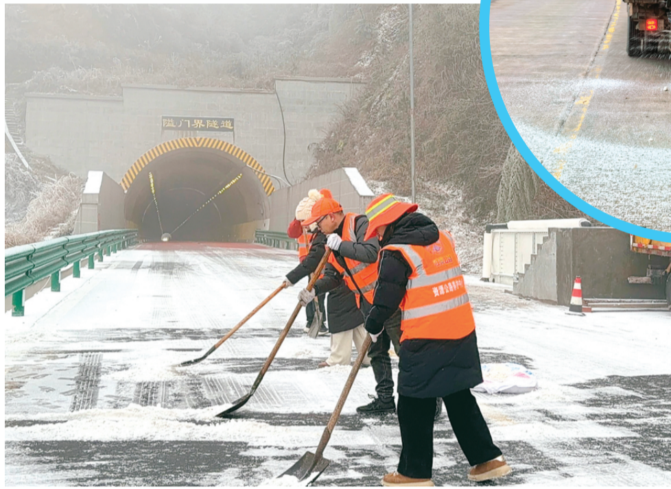
灵川公路养护中心工作人员在国道357大境瑶族乡易结冰路段开展预防性撒盐作业。 通讯员周七发 摄
