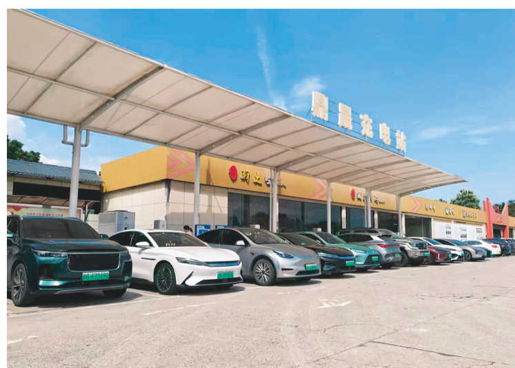
▲鼎晟充电站(桂林方向)超充站设置有2个600千瓦超充终端、10个250千瓦快充终端。 鼎晟能源集团供图
