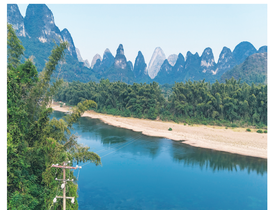
▲跨江线路。(阳朔县融媒体中心 供图)
