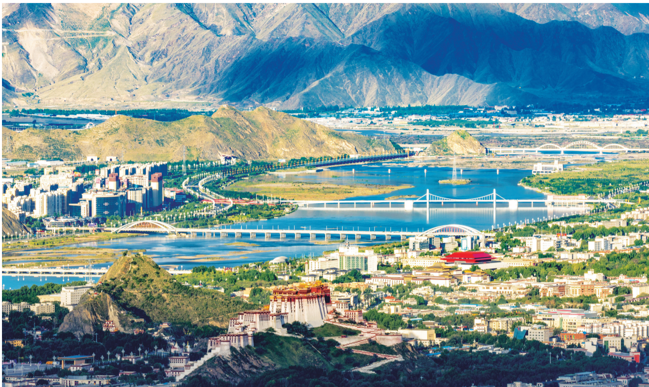
▲这是拉萨河风光（2025年7月30日摄）。由近及远分别是连心桥、柳梧大桥、和美桥和青藏铁路拉萨河特大桥。
