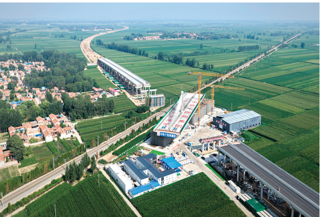
▲这是转体前的斜拉桥（8月6日摄，无人机照片）。当日，在山东德州，由中国铁建投资集团投资建设、中铁十四局集团承建的德州至上饶高速公路（简称“德上高速”）临清连接线跨京九铁路斜拉桥实现精准转体对接。该桥采用不对称塔斜拉结构，高达23500吨。 德上高速是山东省高速公路网的核心组成部分，建成后，山东省综合交通运输体系及高速公路网布局将得到优化。 新华社发（王观生 摄）
