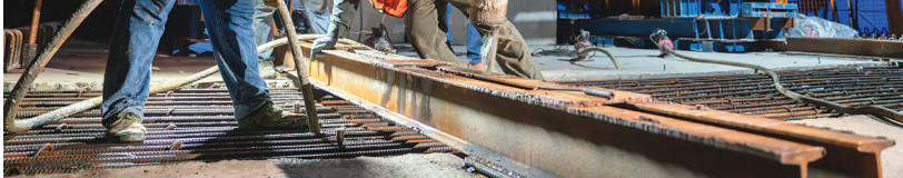
▲ 7 月 6 日凌晨，在邵永高铁跨 S236 省道大桥施工现场，中铁五局工人进行连续梁合龙施工。当日，在湖南省永州市东安县芦洪市镇，邵永高铁全线首座连续梁——跨 S236 省道大桥连续梁成功合龙。
