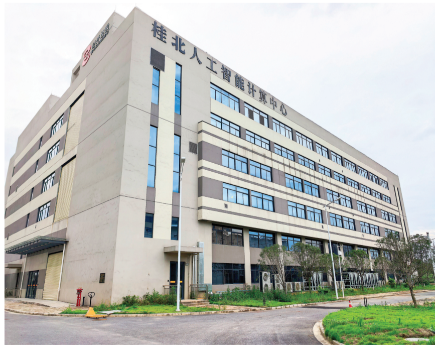
▲正在建设中的桂林华为云计算数据中心二期项目。 杨昌福 摄
