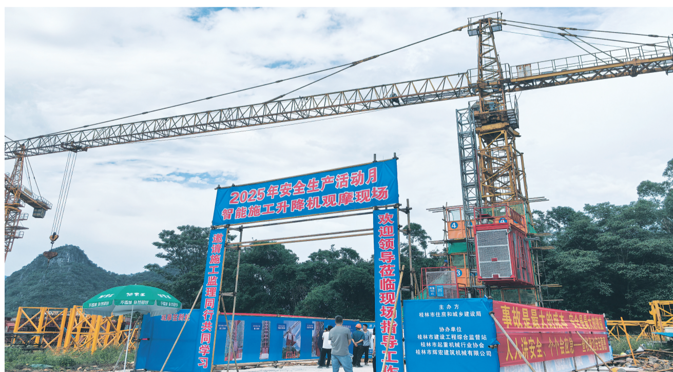
▲在市住建系统安全生产月系列活动中,首次亮相的无人驾驶智能货用施工升降机成为全场焦点。 记者陈静 摄
