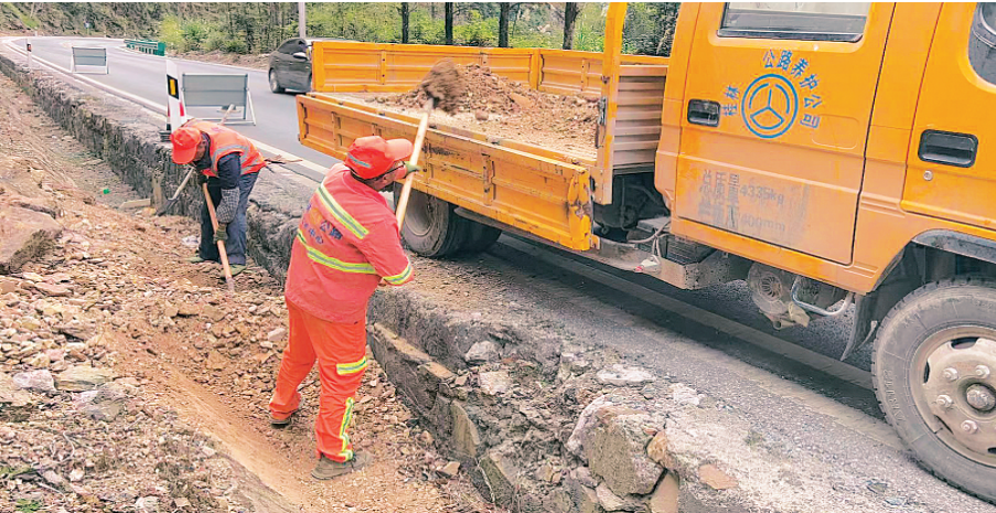
▲ 临桂公路养护中心职工在国道321线东长岭路段疏通公路水沟。 陈元涛 摄
