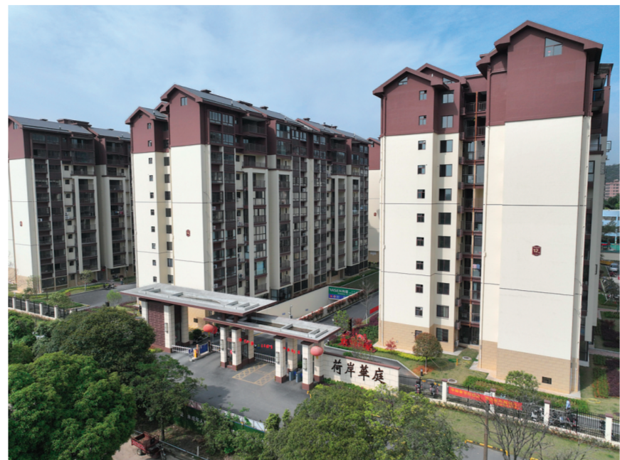
▲桂林齿轮厂危旧房改住房第一期南岸华庭建成交付。
