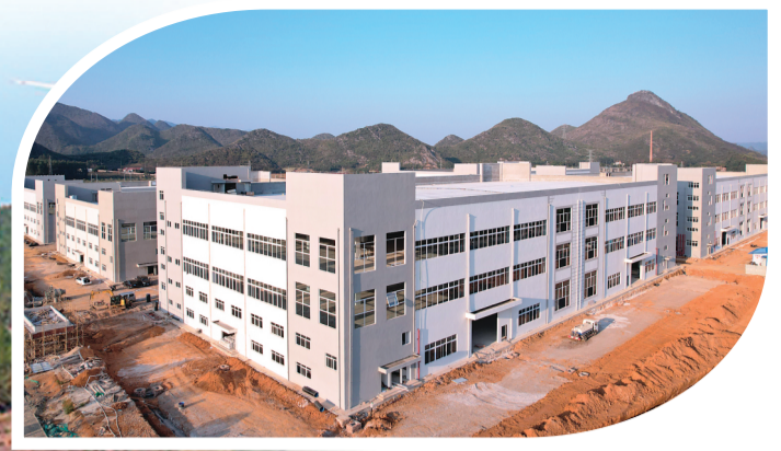
▲工业园区建设如火如荼。
