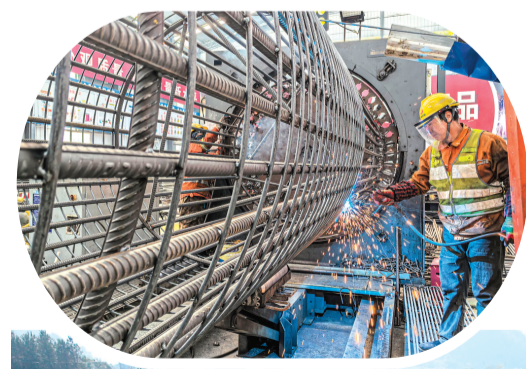
工人正在进行焊接作业。阳海翔 摄
