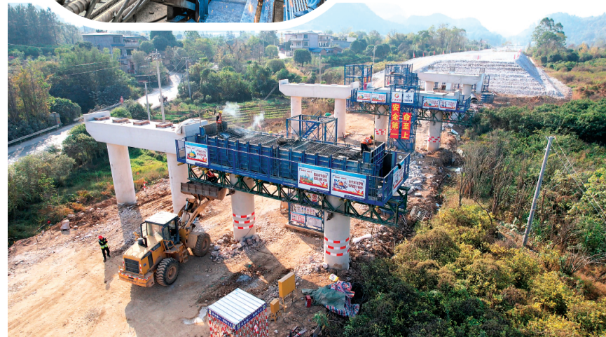
工人正在墩柱上作业。张松铭 摄
