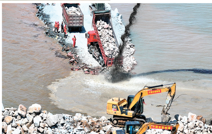
◀▼7 月 8 日，在湖南省岳阳市华容县团洲垸洞庭湖大堤决口现场，抢险队伍在进行堵口作业（无人机照片）。 新华社记者陈振海 摄
