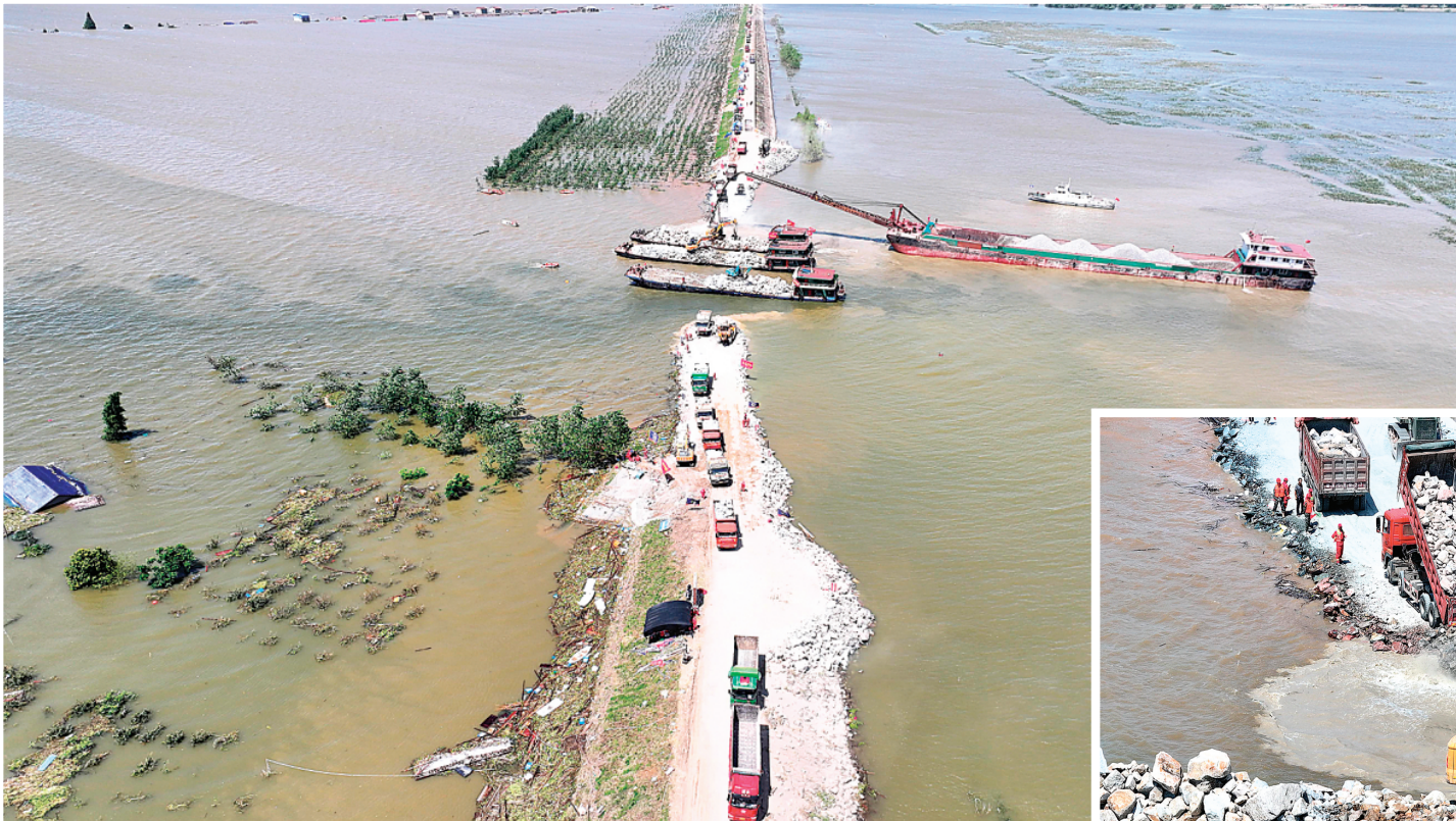
◀▼7 月 8 日，在湖南省岳阳市华容县团洲垸洞庭湖大堤决口现场，抢险队伍在进行堵口作业（无人机照片）。 新华社记者陈振海 摄
