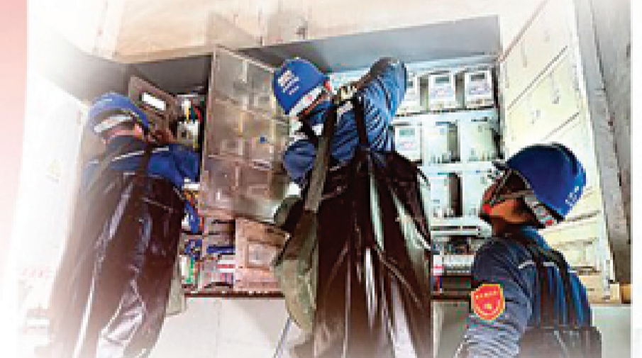
▲6月22日，南方电网广西钦州新区供电局青年突击队队员们负责对漓江壹号公馆变低电压接箱入户断路器进行更换，接通入户线。 陈心斌 摄
