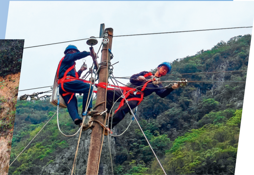
▼施工人员正在杆上开展导线修复工作。 苏祺华 摄
