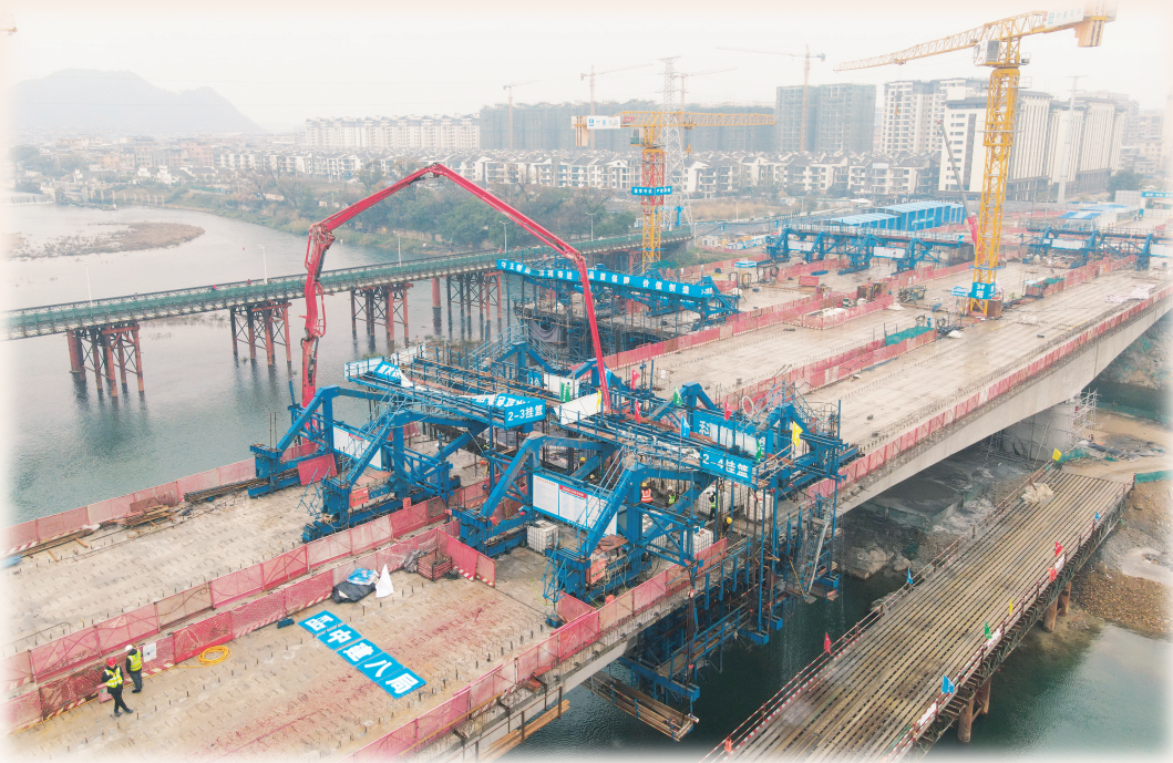
▲新建净瓶山桥右幅辅道桥现浇箱梁合龙浇筑现场。 唐毓健 摄
