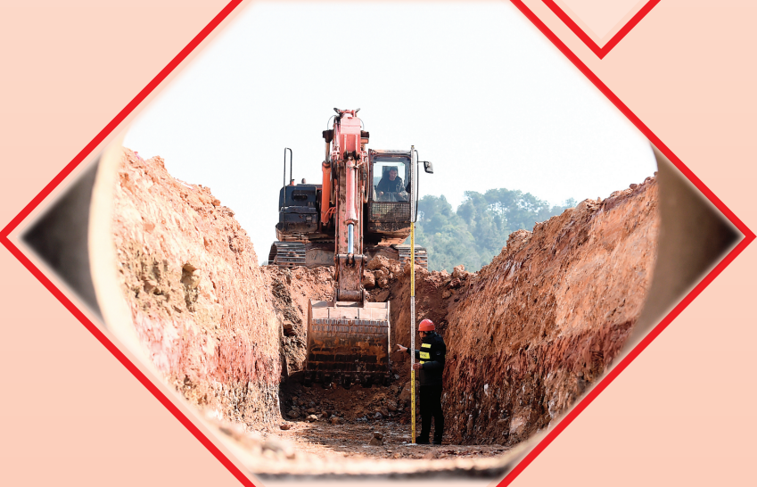
►挖掘机的挖土埋设管道。 记者李忠波 摄
