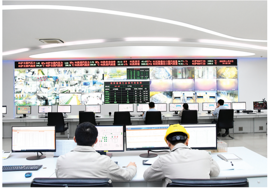
↑在山口生活垃圾焚烧发电厂，工作人员通过大屏幕实时监控垃圾投料、焚烧、尾气处理、炉渣排出等各个环节的画面和数据。
